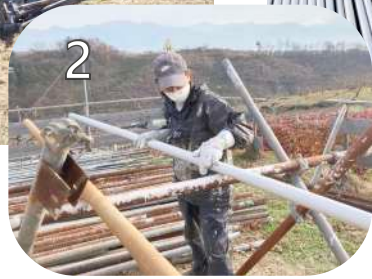
1. 雨よけ部材塗装前。まず錆落としから。/ 2. パイプのような丸い断面のものは軍手にペンキをつけて 塗るとローラーや刷毛塗りよりも段違いに早い。/ 3. 塗装完了！乾いたら運搬、設置場所近くへ。
